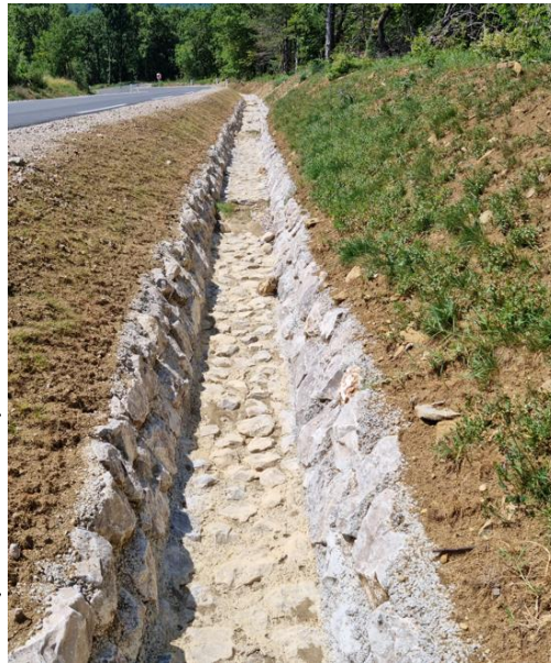
Slika 5: predvidena ureditev jarka s tlakovanjem dna s kamnom v betonu
